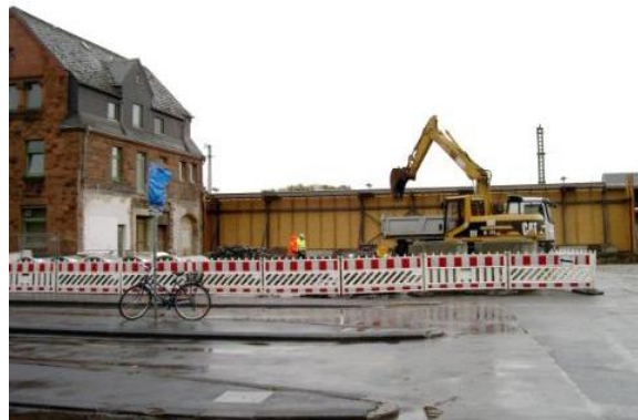
Abbruch Expressguthalle, Baudurchführung
