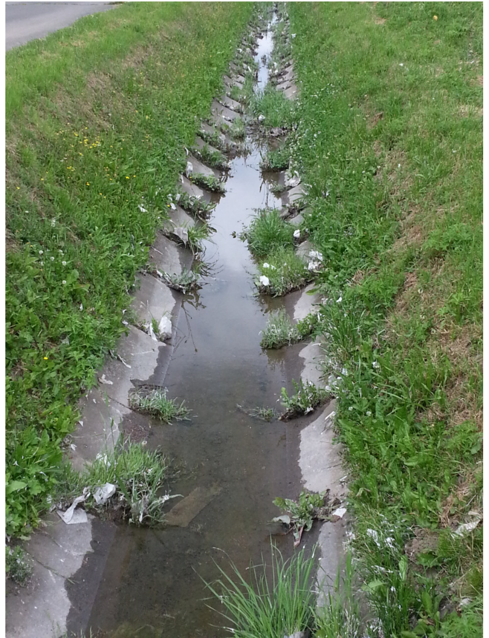
Graben hinter beiden Unterführungen
