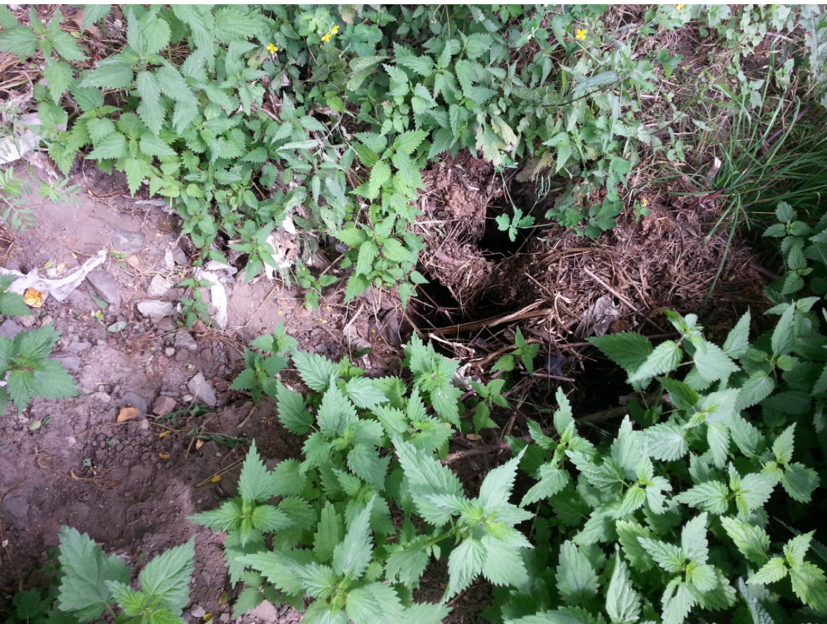
Autritt in Gelände vor Unterführung
