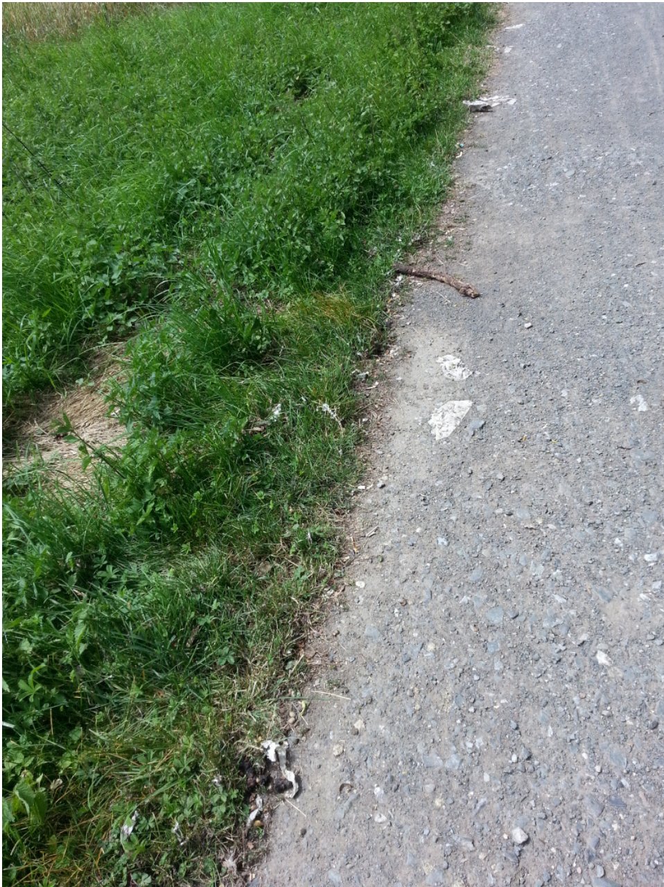
Rad-u. Fußweg vor Unterführung
