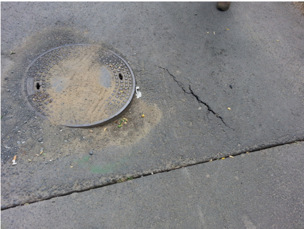
Kanaldeckel hinter Unterführung
