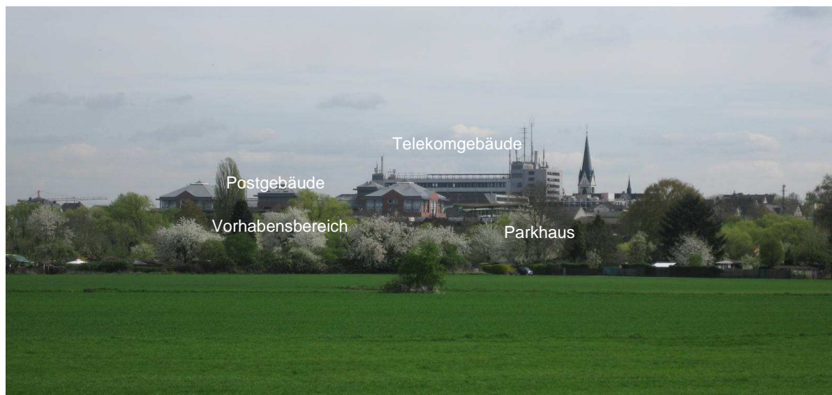
Foto 1: Blick auf die bisherige Stadtansicht von Westen (Standort nahe Gießener Ring bei Gewerbegebiet-West). Der Vorhabensbereich befindet sich links neben dem vorhandenen Parkhaus vor dem östlich der Gleisanlagen befindlichen Postgebäude. Im Hintergrund ragt das Telekomgebäude hoch auf, rechts daneben die St. Bonifatiuskirche. Im Vordergrund: Kleingärten westlich der Lahn.
