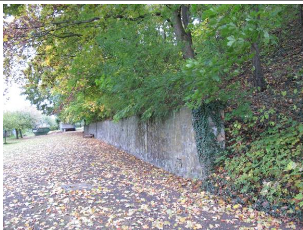
Bereich am Günthersgraben unterhalb der begrünten Böschung
