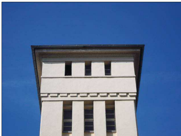
Abb. 17: Oberste Fenster des Feuerwehrturms des Poppe-Geländes stehen offen.
