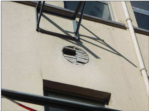
Abb. 13: Offener Lüftungsschacht an alter Werkshalle des Poppe-Geländes
