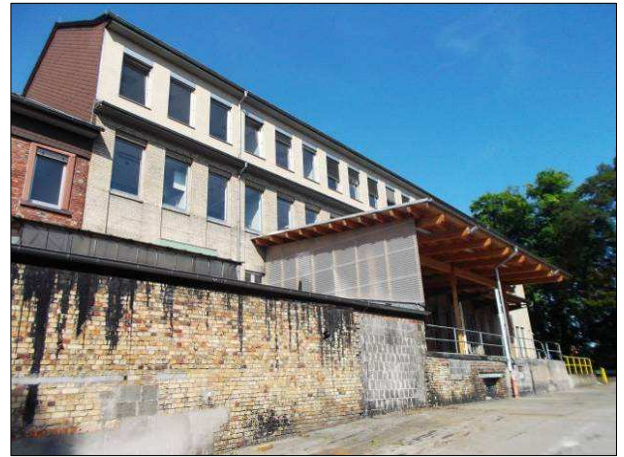
Abb. 16: Anbau an das ehemalige Verwaltungsgebäude mit Querbalken aus Holz
