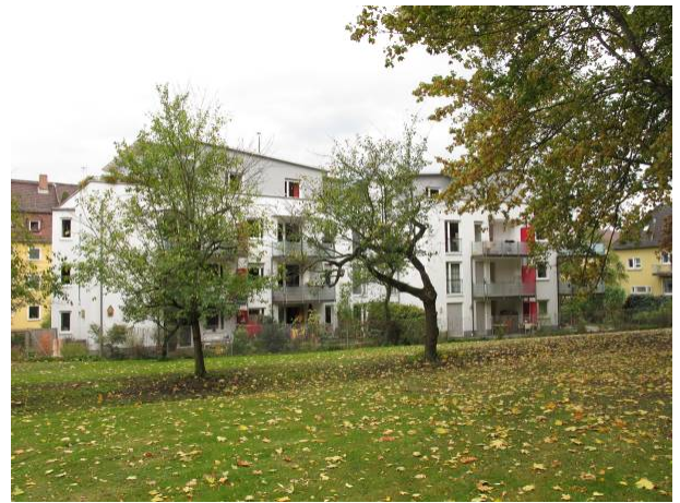
Ansicht Wohngebäude Wilhelmstraße 56a im Nordosten an das Plangebiet angrenzend
