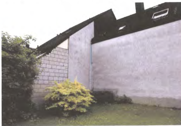
Bild 3: Südwestseite Bauwuch (Planungsbehörde)
