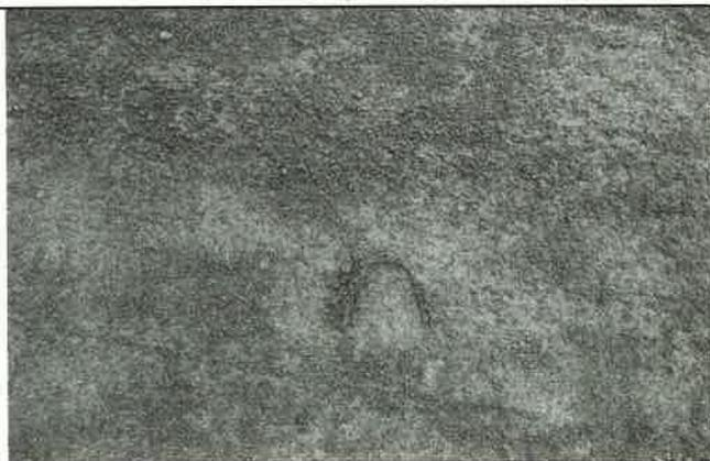
Der durchnässte Tennensportplatz wird auch durch einen einzelnen Fußabdruck ersichtlich. Bei einer Bespielung durch Fußballschuhe (mit Noppen bzw. Tausendfüßler) wäre die Tragschicht „durchgetreten“ worden, dh. die tiefer liegende Sportplatzschicht hätte größere Steine nach oben abgegeben. Eine Verletzungsgefahr wäre für das Spiel gegeben. Nur durch aufwendige Sanierungsmaßnahmen wäre
