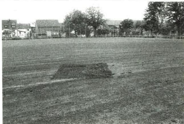
Das Schleppgitter nimmt großflächig den nassen Tennenbelag auf. Der Platzaufbau leidet darunter, so dass Steine aus dem unteren Sportplatzaufbau nach oben befördert werden.
