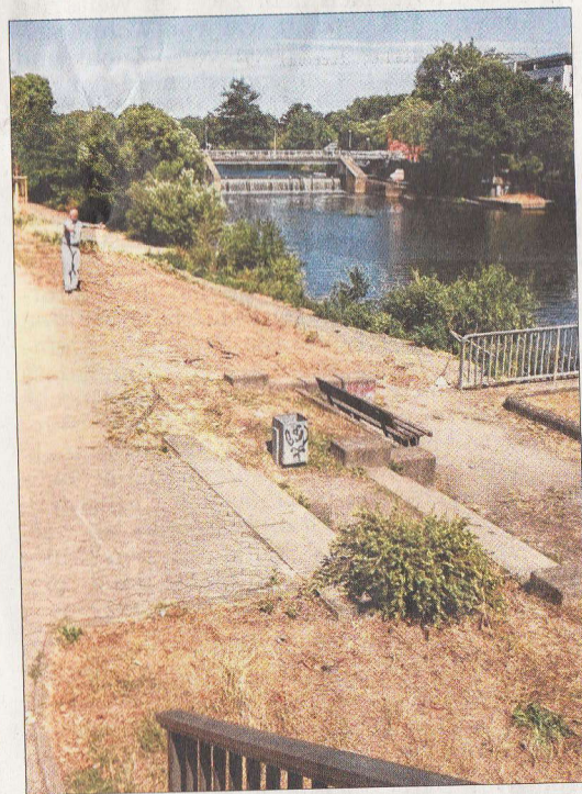
MWB-Mitarbeiter Peter Eschke zeigt's: In die Uferböschung der Lahn wird die Pumpstation Nummer 11 eingebaut. (Foto: mö)
