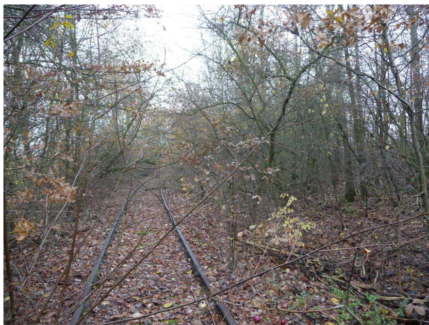
Abb 2: Gleiskörper im Inneren, mit Entwässerungsmulde
