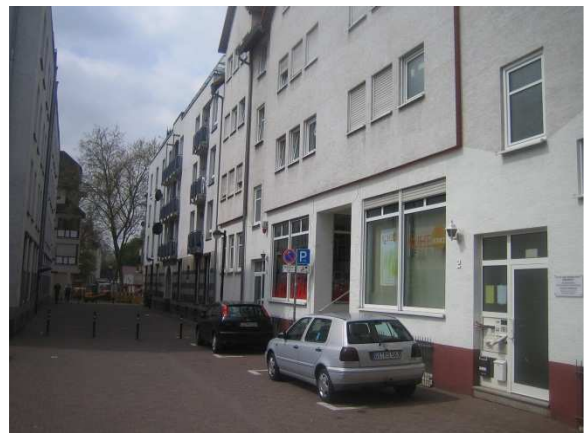
Foto 4: Bebauung Kleine Mühlgasse
