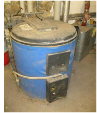
veralteter Warmwasserspeicher
