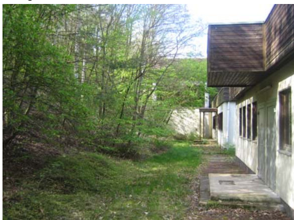
Foto 5: Gehölzbestandene Böschung südlich des Gebäudebestandes
