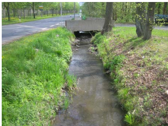
Foto 18: Verlauf des Krebsbaches südlich der Rödgener Straße (bereits außerhalb des Geltungsbereichs)
