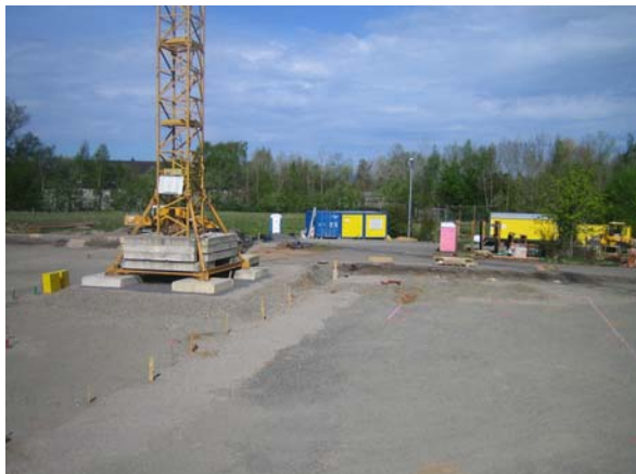
Foto 1: Baustelle der Sophie-Scholl-Schule
