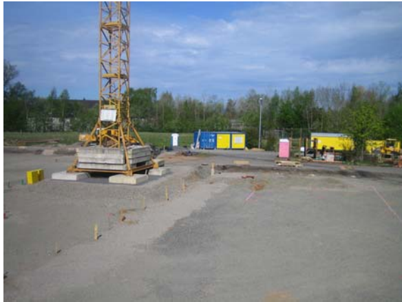
Foto 1: Baustelle der Sophie-Scholl-Schule
