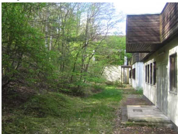
Foto 5: Gehölzbestandene Böschung südlich des Gebäudebestandes
