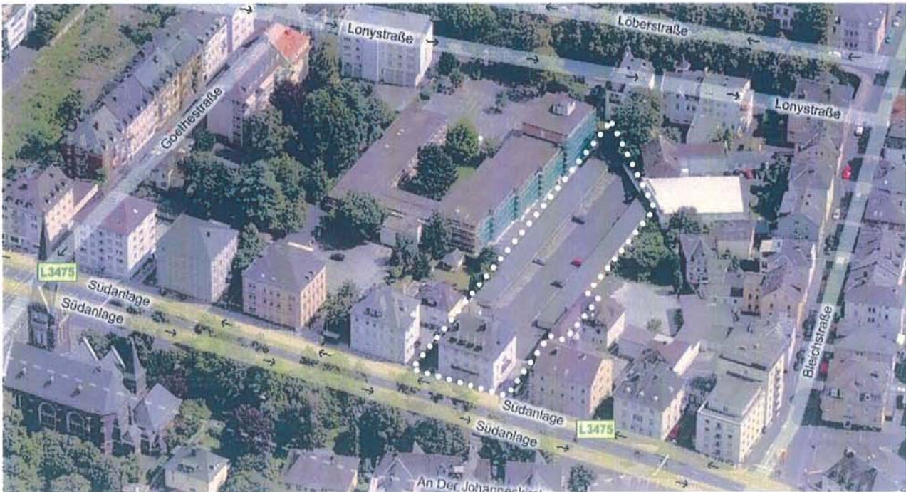
Bild 1: Schrägaufnahme des Gevierts, Blick in etwa nach Süd-Südost (Quelle: www.bing.com)
