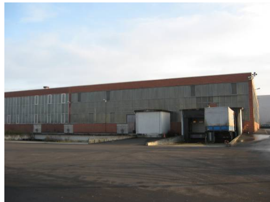
Logistik-Halle im Nordteil
