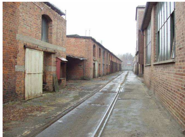
Abb. 12: Lagerhallen im südlichen Teil
