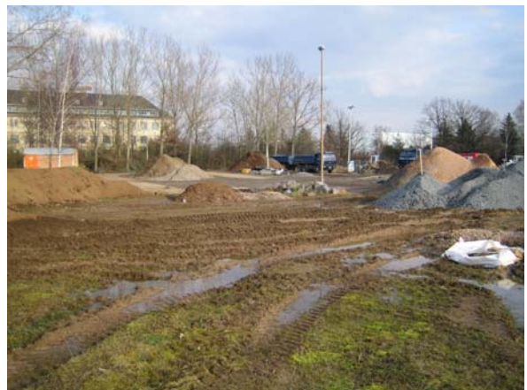
Foto 4: Bauschutt-Recycling-Flächen von Nordwesten
