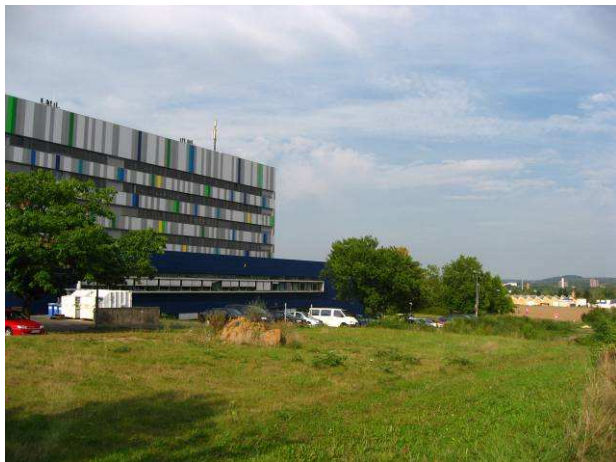
Freifläche nördlich der Straße Schwarzacker
