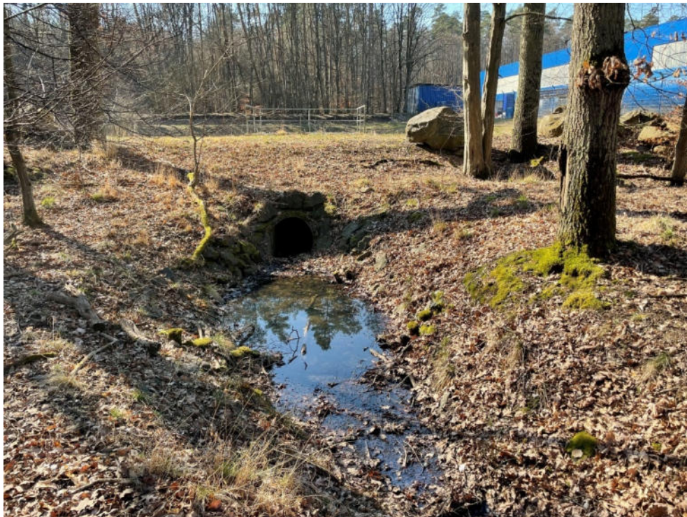
Abb. 24: Befestigter Graben und Einlaufbauwerk zum Hochwasserrückhaltebecken (Foto: M. Grenz)
