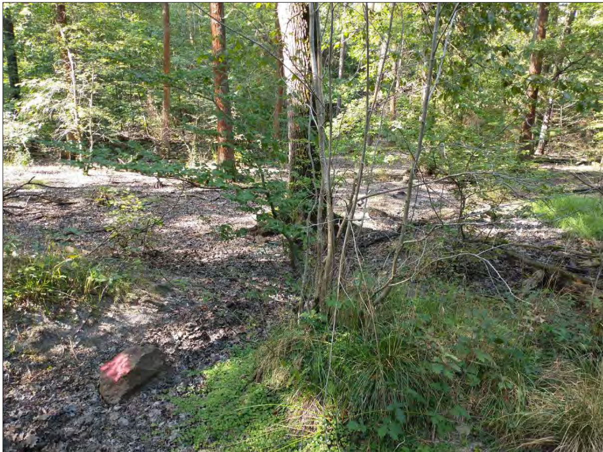
Abb. 18: Blick nach Norden entlang des Entwässerungsgrabens
