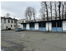
Foto Nr. 4: Ansicht Ost (Hofansicht), Hintergrund Wohnhaus
