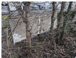
Foto Nr. 3: Ansicht West (Blick vom Bahndamm)
