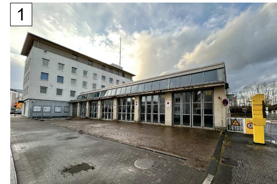
Foto Nr. 1: Ansicht Süd-Ost Fahrzeughalle (Straßenansicht) (rechts Fahrzeughalle, links Mittelbau)
