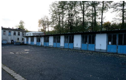
Foto Nr. 2: Ansicht Ost (Hofansicht)
