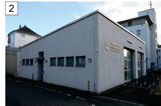
Foto Nr. 2: Ansicht Nord Sozialtrakt
