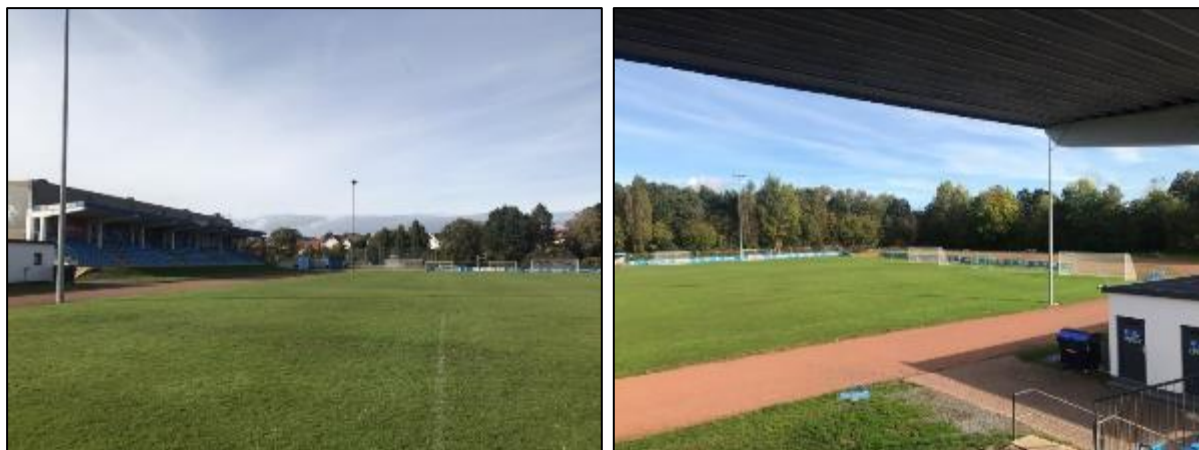
Abbildung 10: Blick in östliche Richtung auf das Großspielfeld mit Laufbahn (rechts) und in nordwestliche Richtung auf die Tribüne (links)
