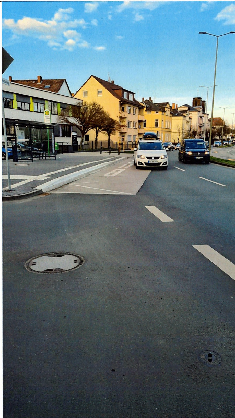
Bushaltestelle Nordanlage – sogar in der Fahrbahn!
