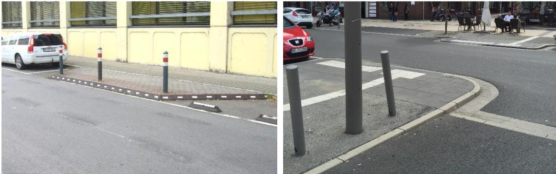
Beim Einsatz dieser Querungsanlage wird die Querungsdistanz verkürzt, die Sichtbeziehungen zwischen den Verkehrsteilnehmenden (insbesondere bei Kindern) werden verbessert und der Abbiegeradius verringert und damit einhergehend reduzierte Kfz-Abbiegegeschwindigkeiten. Damit sind sie ein geeignetes Mittel, um das Queren einer Straße zu erleichtern und sicherer zu machen.
