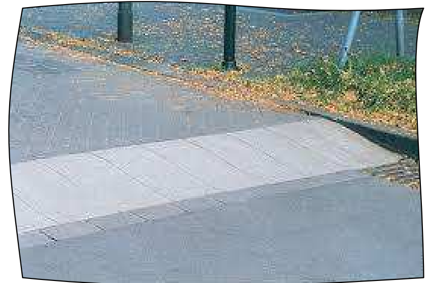
System ... „Fahrbahn anheben“
