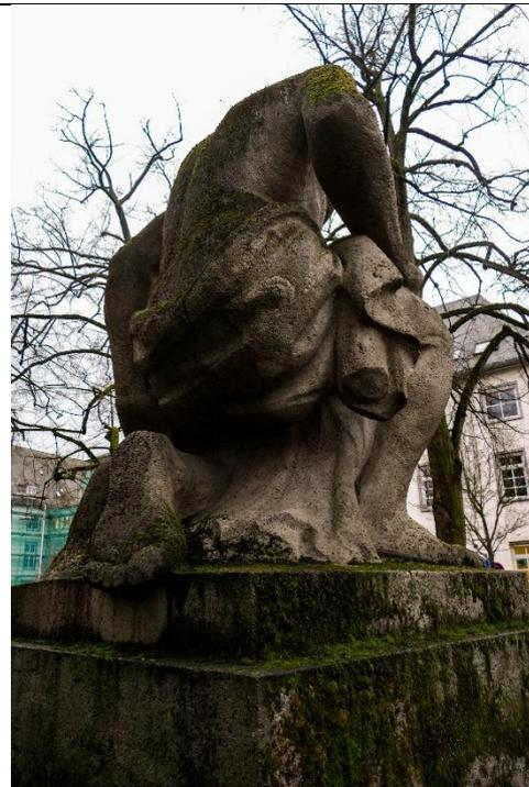
Abb. 71 Starker biogener Bewuchs aus Algen, Moosen und Flechten, die sich besonders an Flächen mit Hohlräumen im Gestein ablagern.
