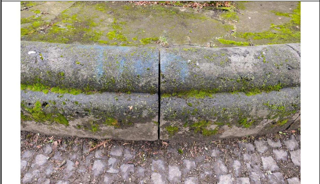
Abb. 83 Offene Stoßfuge zwischen den Werksteinen des Beckenrands. Diese sind bei der Sanierung mit fließfähigem, hydraulischem Mörtel zu vergießen und ggf. zusätzlich mit Blei zu verstemmen.
