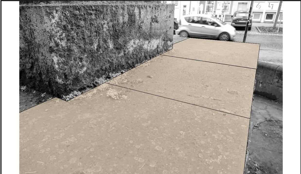
Abb. 78 Segmentierung der Deckplatten auf der Oberseite des Postaments; hier Nordostseite.
