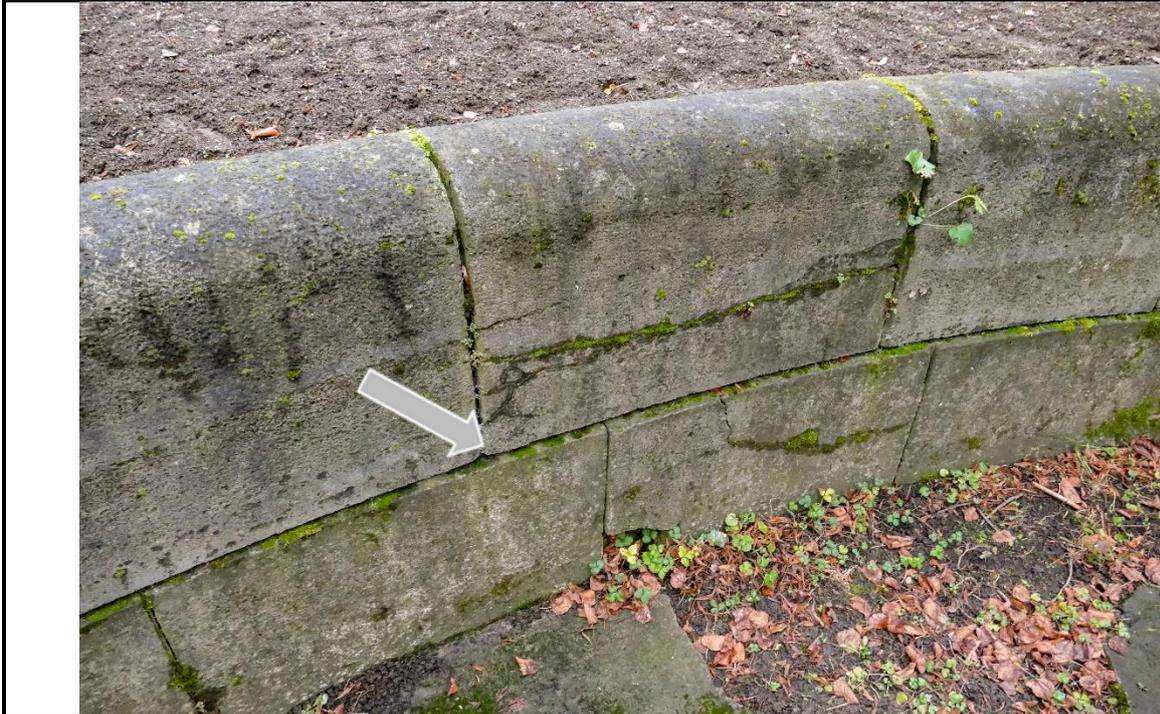
Abb. 80 Beckenrand aus gerundet geführten Werksteinen. An einigen Abschnitten wie hier an der Ostseite sind die Quader gegeneinander verschoben.
