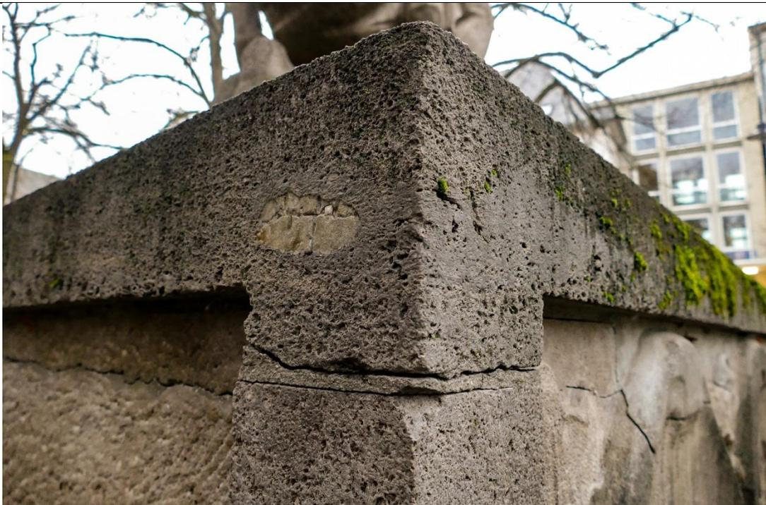
Abb. 75 Rissverlauf am östlichen Eckpfeiler durch eine Lagerfuge hindurch. Der Spalt deutet auf eine Anhebung der Deckplatte hin.
