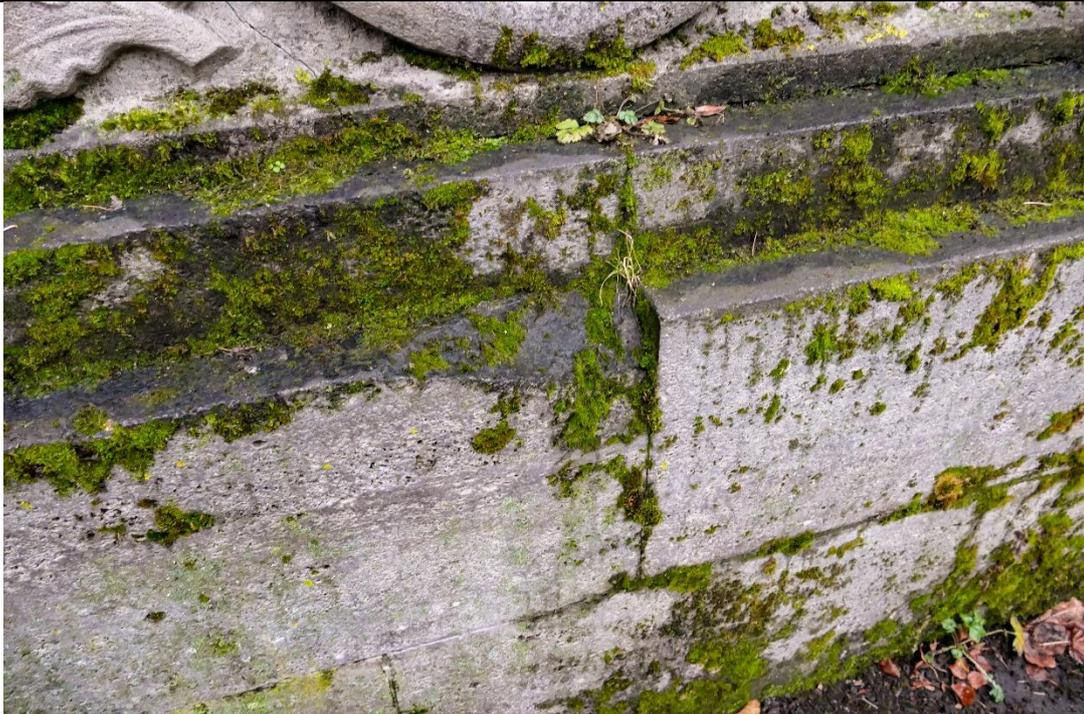
Abb. 72 Der biogene Bewuchs lagert sich u.a. in den Mörtelfugen ab und führt hier zu einem Feuchtestau und begünstigt die Entfestigung.
