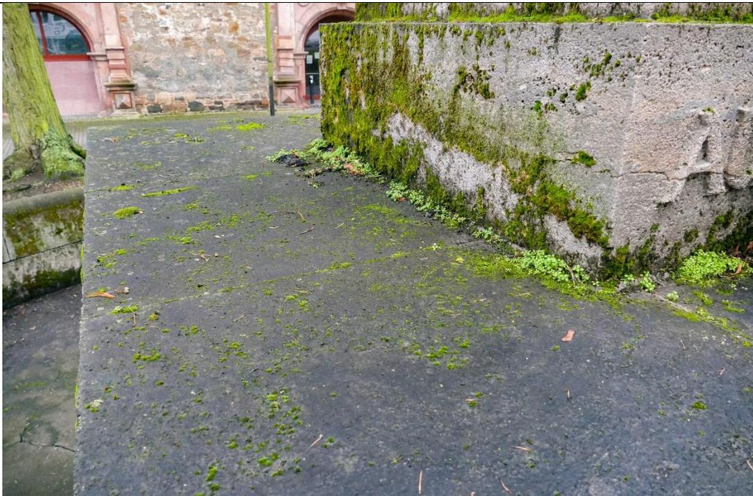
Abb. 73 Oberseite des Postaments mit dunklen Krusten und nur geringem, biogenen Bewuchs. Über die schmalen und größtenteils schadhaften Pressfugen kann Feuchtigkeit an den Kernaufbau gelangen.
