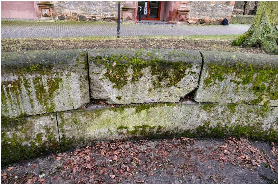
Abb. 81 Beschädigter Werkstein im südlichen Beckenrand.
