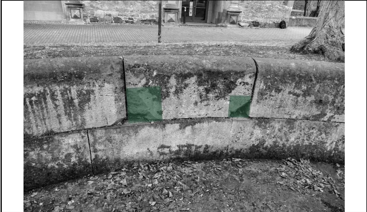
Abb. 82 Die Schadstellen sind durch Einbau von zwei Vierungen wiederherzustellen (grün).
