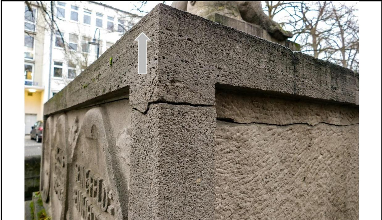
Abb. 76 Rissverlauf am südlichen Eckpfeiler durch eine Lagerfuge hindurch. Der Spalt deutet auf eine Anhebung der Deckplatte hin, die möglicherweise durch die Last der Figur im Zentrum nach unten gedrückt wird und somit an den Rändern ansteigt.
