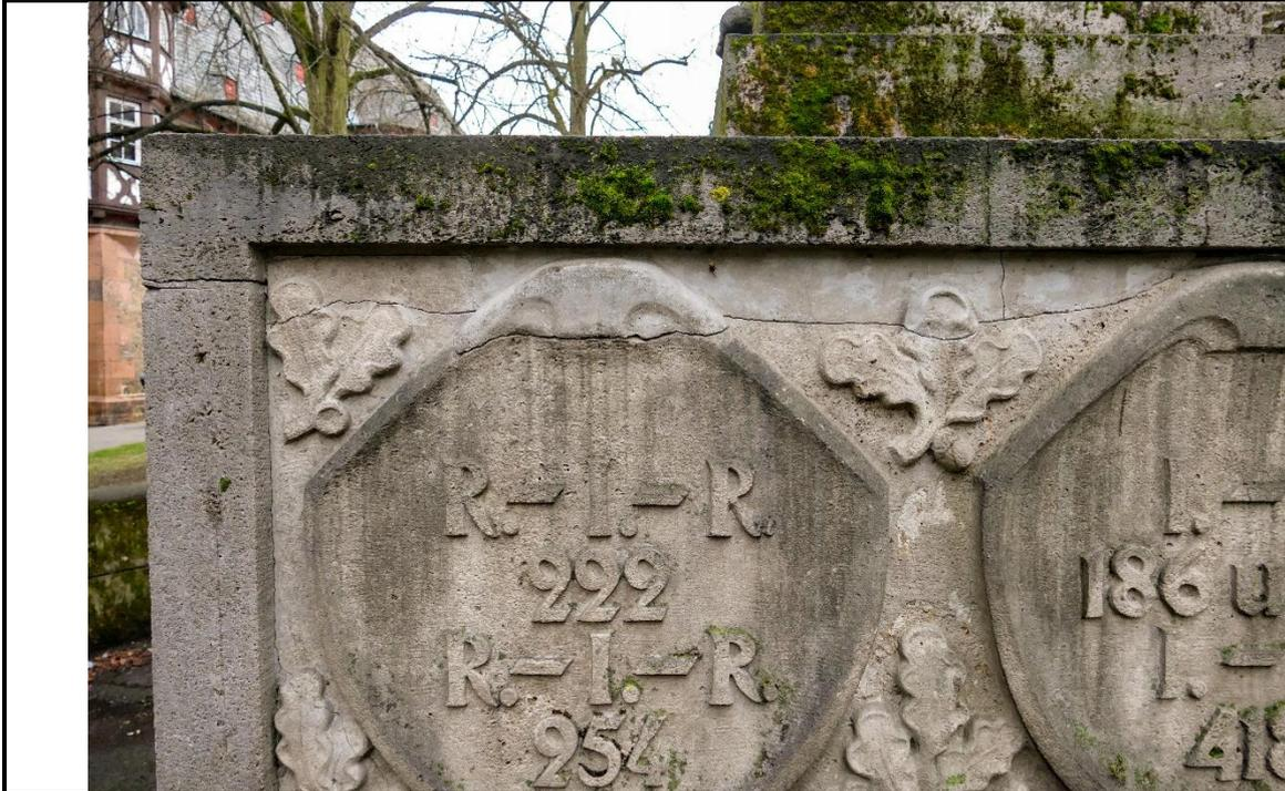
Abb. 74 Rissverlauf in der Nordostseite der Reliefzone und durch eine Zement gebundene Mörtelausbesserung hindurch. Die Flanken der Ausbesserung sind abgerissen.
