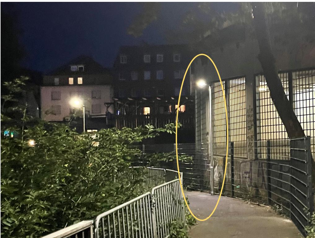
*Abbildung 2* Weg zur Unterführung nach Verbesserung der Beleuchtung (zusätzliche Leuchte umrahmt)
