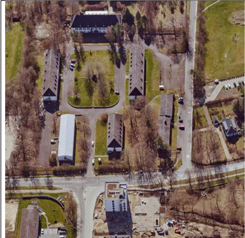
Abbildung 9: Blick von Norden (Rödgener Straße nach Süden) Luftbild: Stadt Gießen
