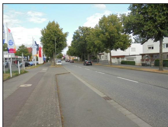
Abb. 15: Abschnitt der Marburger Straße mit straßenbegleitenden Linden im Süden des Plangebietes
