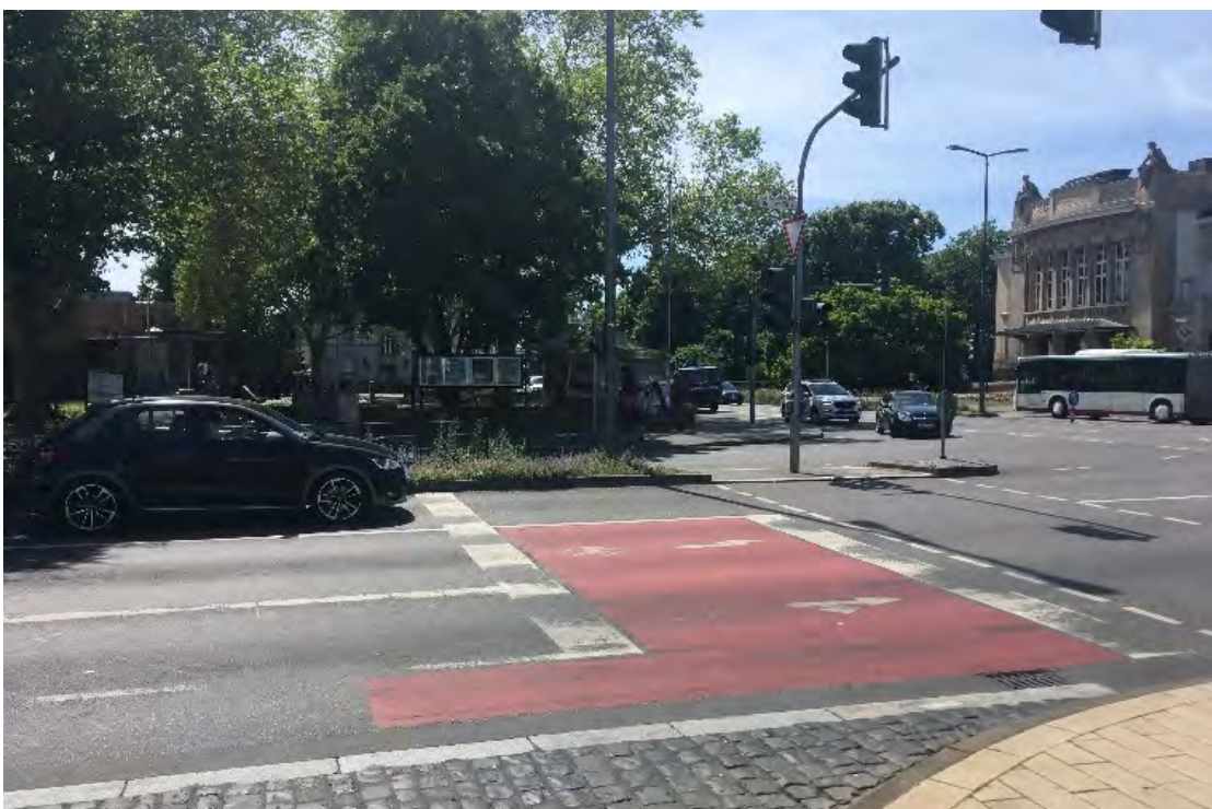
Abbildung 29: Erschwerte Linksabbiegemöglichkeit trotz Aufstellfläche im fließenden Verkehr
