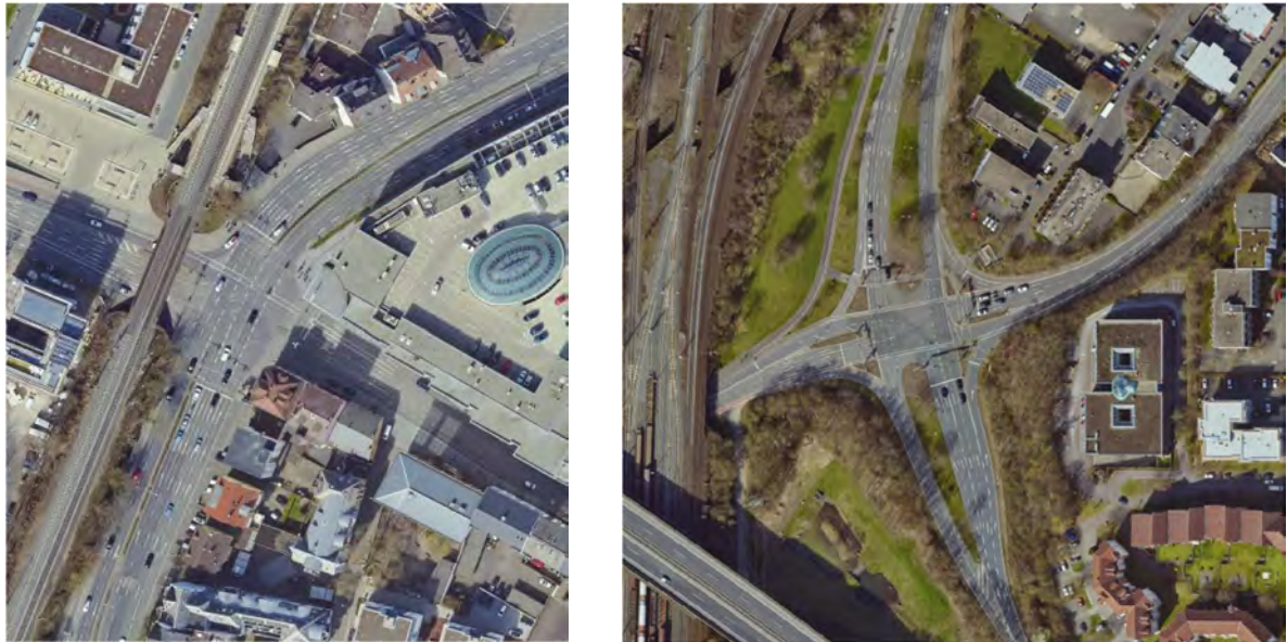
Abbildung 40: Groß dimensionierte Knotenpunkte
