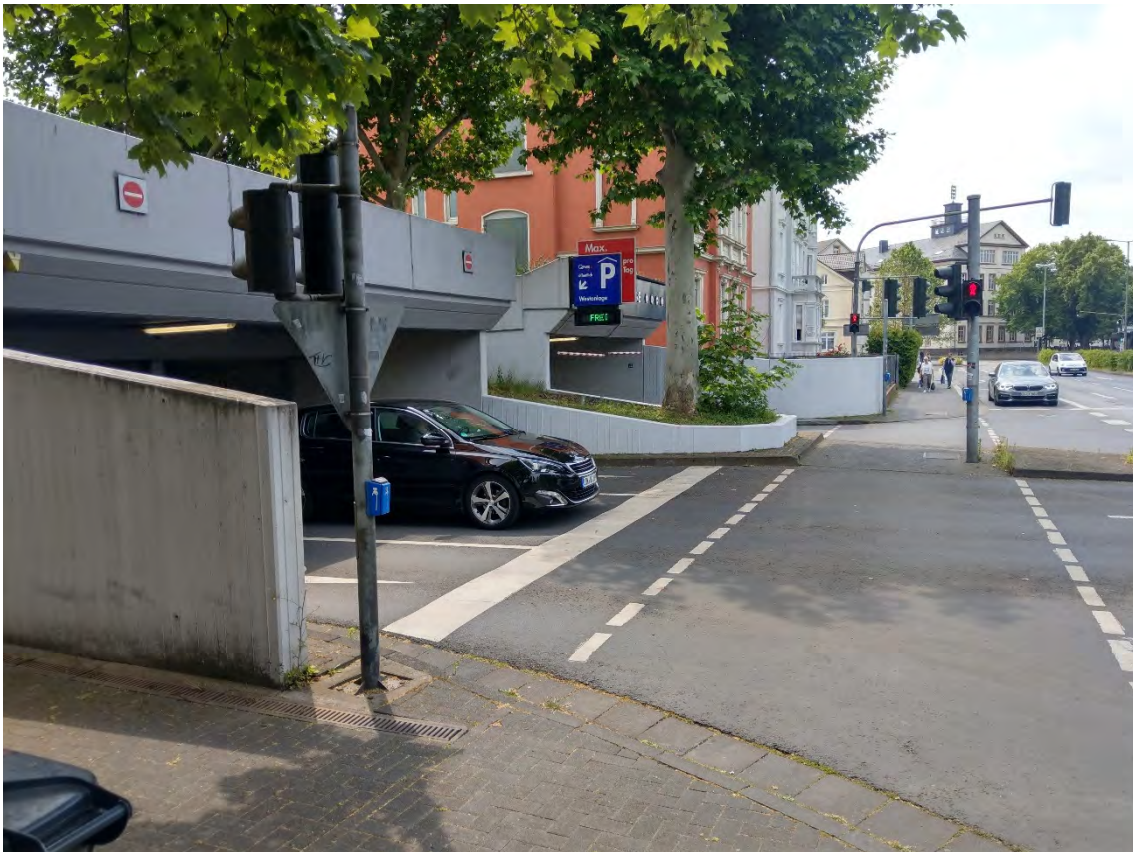
Abbildung 48: Eigene LSA für die Ein- und Ausfahrt des Parkhauses Westanlage
