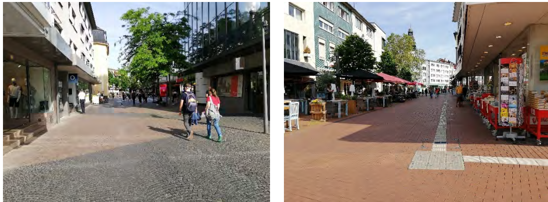
Abbildung 13: Kontrastarmes, kleinteiliges Pflaster auf dem Neuenweg (links); gut integriertes Leitsystem nebst gut begehbarem, glattem Pflaster im Umfeld Kreuzplatz (rechts)
