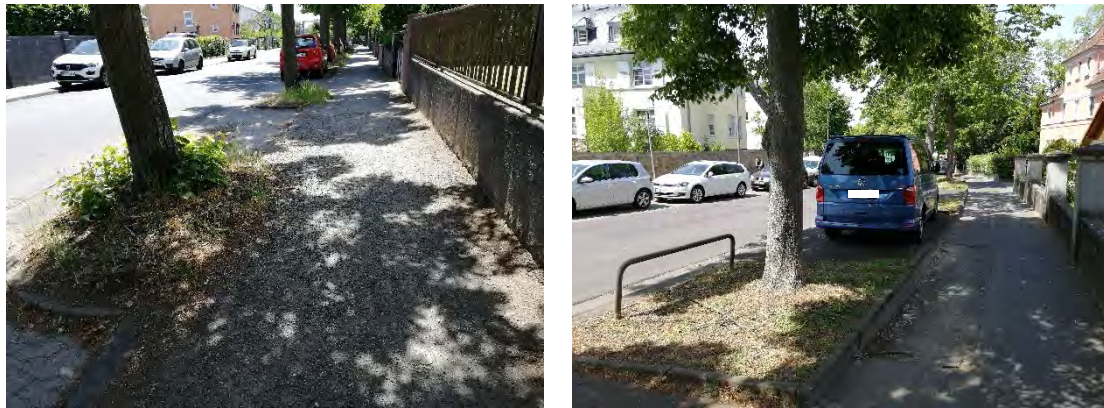
Abbildung 12: Eingeschränkte Barrierefreiheit durch unbefestigte Gehwege und Wurzelwerk im Wartweg (links) sowie fehlendes Pflaster in der Friedrichstraße (rechts)
