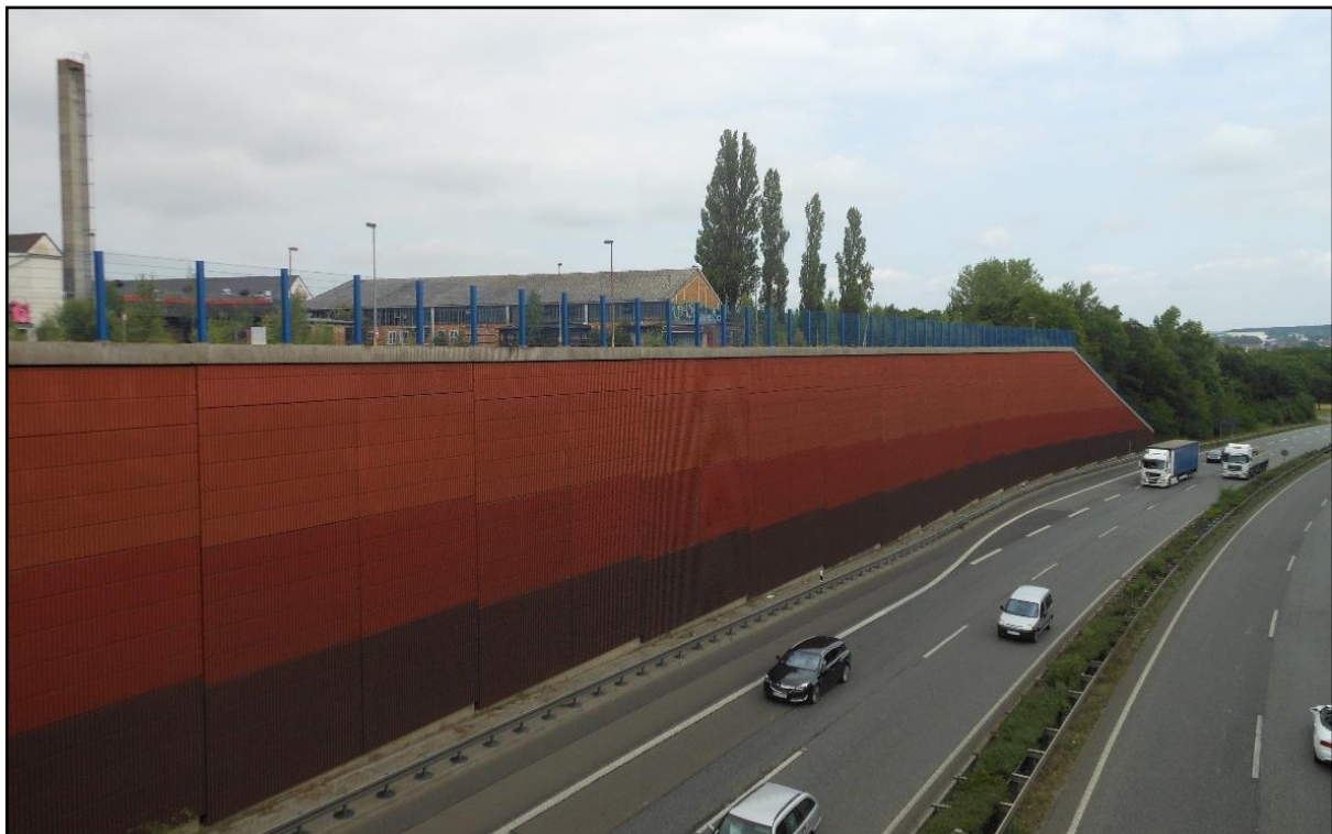
Abb.: 4-10: Lärmschutzwand entlang des Gießener Rings
