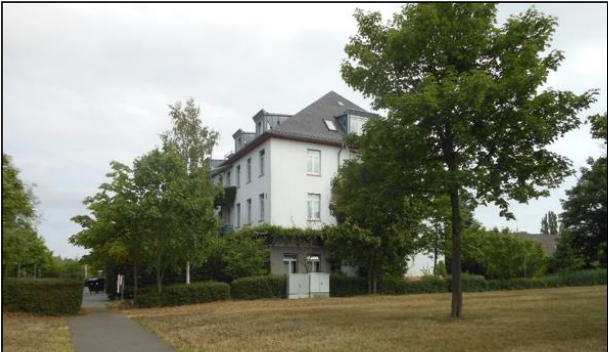
Abb.: 4-11: Wohngebäude Ernst-Toller-Weg 1-3
