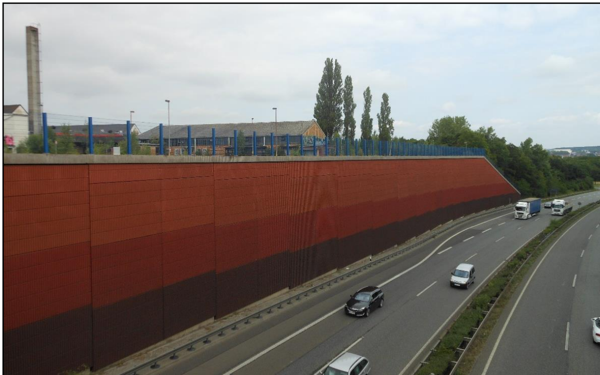
Abb.: 4-10: Lärmschutzwand entlang des Gießener Rings
