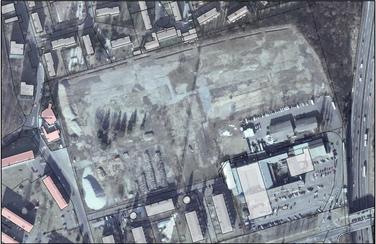
Abbildung 2-2: Luftbild 2003 (ohne Maßstab): Die Fläche ist nahezu komplett geräumt und wurde saniert. Die Gehölzinsel ist aufgrund ihres Nadelholzanteils gut zu erkennen, aber auch die Platanen und der Bergahorn sind – aufgrund des Aufnahmezeitpunkts laubfrei - noch da.
