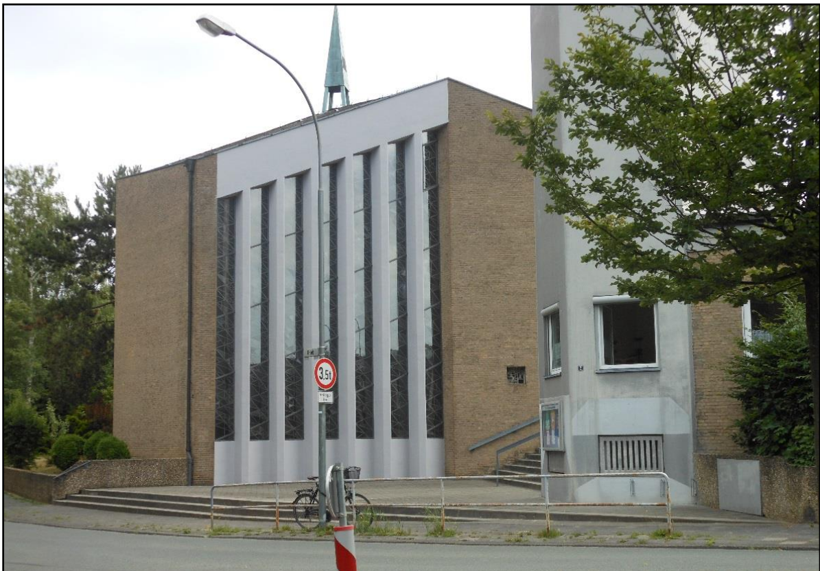
Abb.: 4-5: Kirche und Gemeindezentrum der Wicherngemeinde
