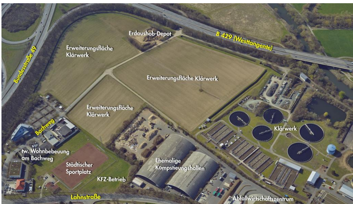
Abb. 5 Bebauung und Erschließung/Verkehrswege im südwestlichen Teil des Plangebietes
