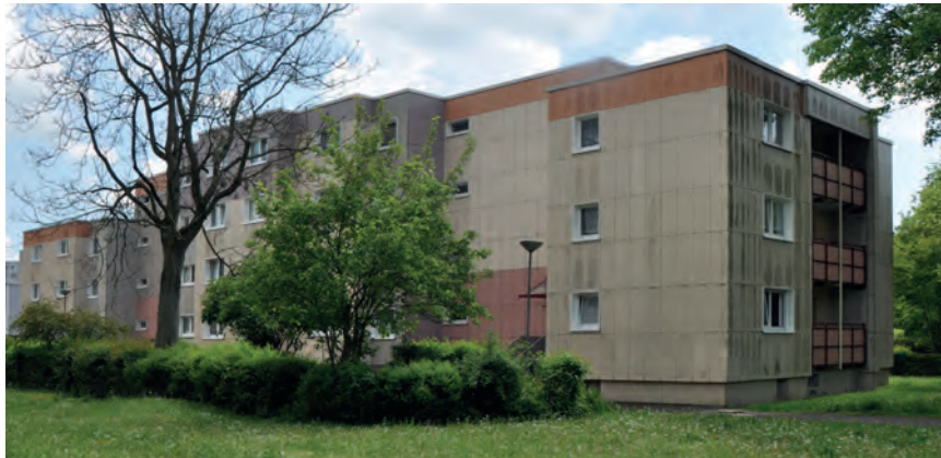
Aufwertung und Sanierung von Gebäuden – Paul-Schneider-Straße
