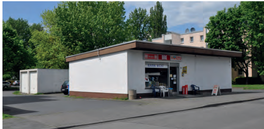
Quartiersplatz Umfeld Kiosk Pater-Delp-Straße
