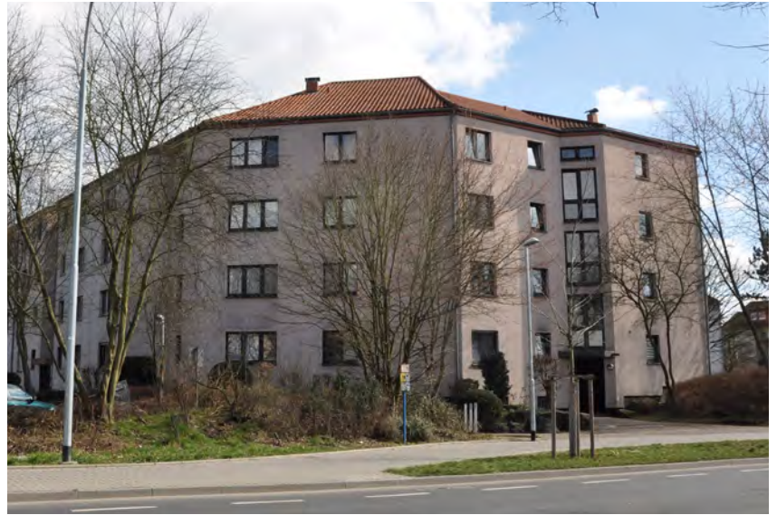
Geschosswohnungsbau Schwalbachacker, GWH
