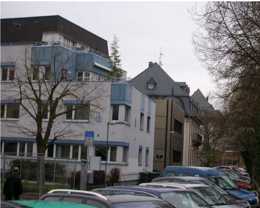
Abb. 6: Blick auf Lonystraße 9 bis 7 (von vorne nach hinten) aus Richtung Südwest (PBKoch, 2008)
