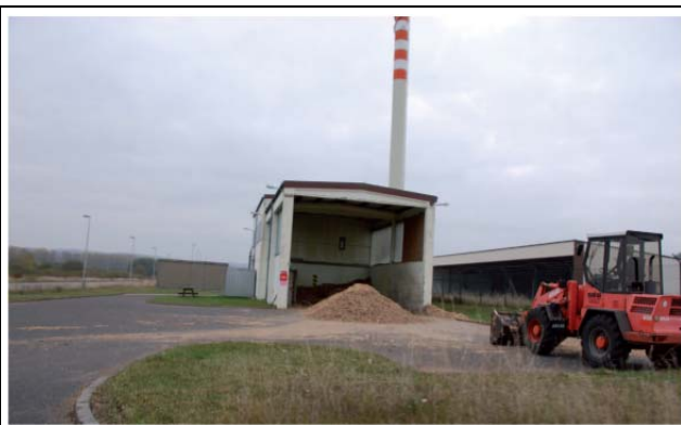
Holzheizwerk im Nordosten des Plangebietes
