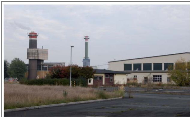
Gasheizwerk im Westen des Plangebietes
