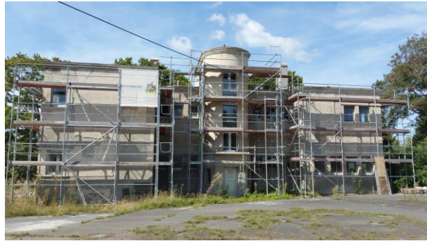
Quelle Revikon, denkmalgerechte Sanierung 2016
