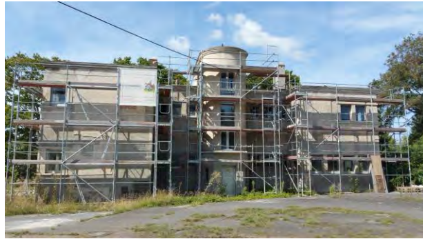
Quelle Revikon, denkmalgerechte Sanierung 2016
