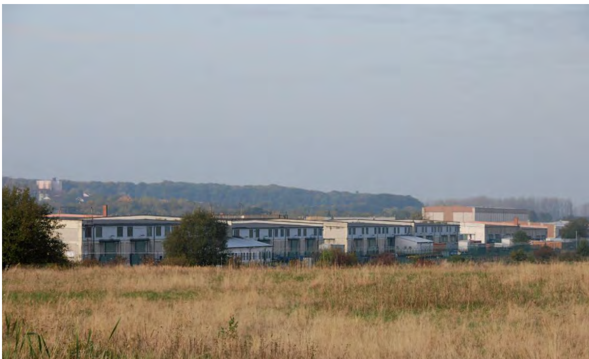
Blick von Nordosten auf die Hallen und das Verteilungszentrum (rechts im Bild) des AAFES-Geländes
