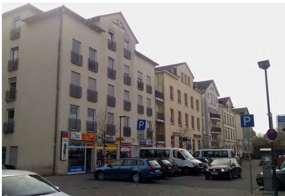
Vorderansicht von der Bahnhofstraße
