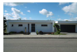
Hofacker 18 Oberkante Dach +3,49 m
