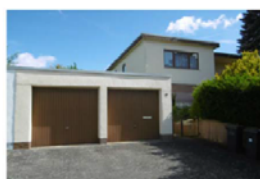
Hofacker 17 Oberkante Dach +8,16 m
