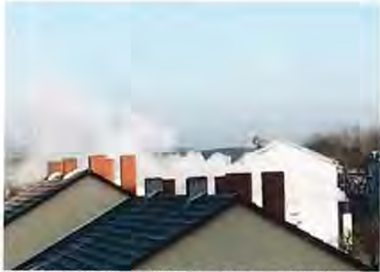
BHKW im Bereich der Troppauer Straße (eigene Aufnahme vom 06.01.2017)
