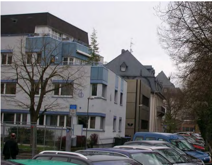
Abb. 6: Blick auf Lonystraße 9 bis 7 (von vorne nach hinten) aus Richtung Südwest (PBKoch, 2008)
