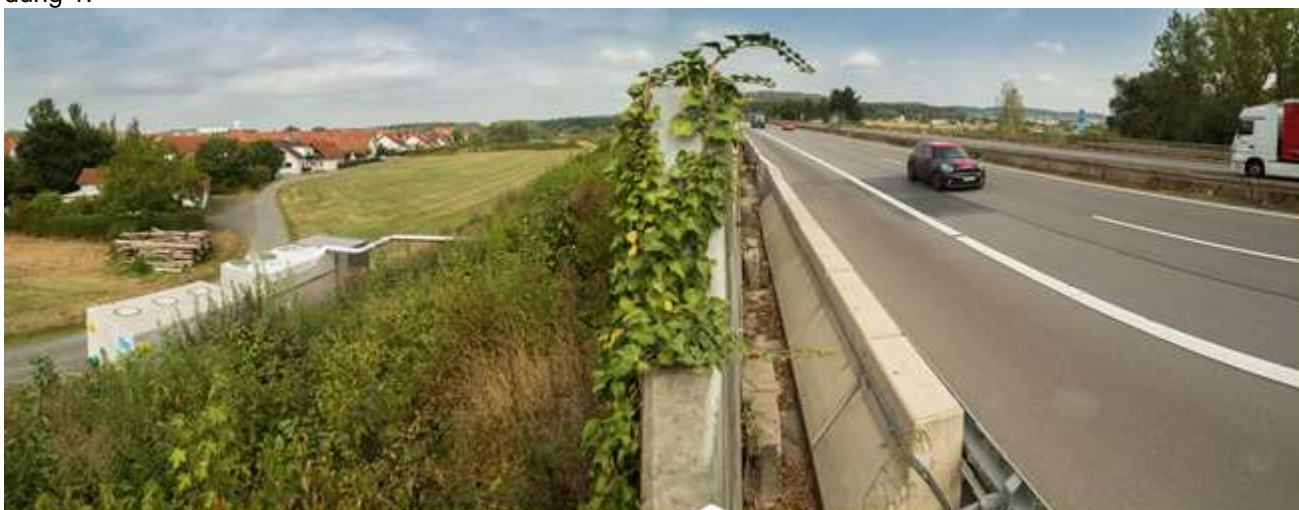
Abbildung 1: LOEWE-Behandlungsanlage für Niederschlagswasser an der A 485 in Gießen-Wieseck [HA Hessen Agentur GmbH – Jan Michael Hosan, 2016]
