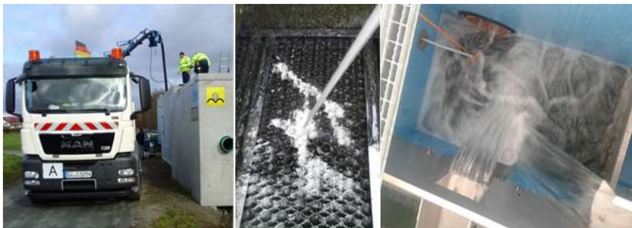
Abbildung 5: Entleerung und Reinigung der Anlage (links, Mitte); Übergang Lamellenabscheider in Filterstufe bei Q_{max} (rechts)
