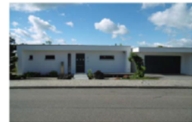
Hofacker 18 Oberkante Dach +3,49 m
