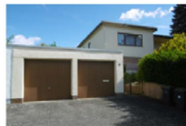
Hofacker 17 Oberkante Dach +8,16 m
