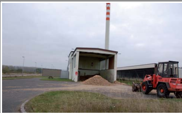
Holzheizwerk im Nordosten des Plangebietes
