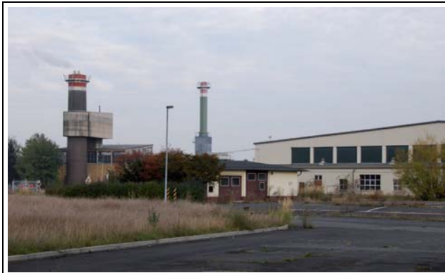
Gasheizwerk im Westen des Plangebietes
