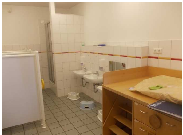
Kita: Waschraum 2 -> Erweiterung geplant
