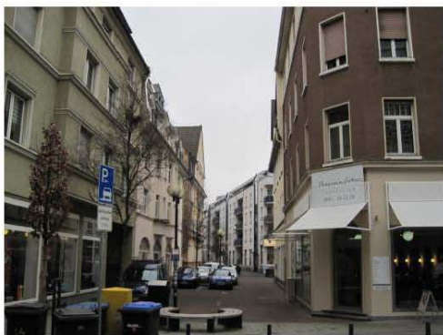
Mühlstraße – Blick aus Südost
