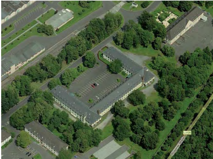
Schrägluftbild ehem. Verwaltung/ Support
