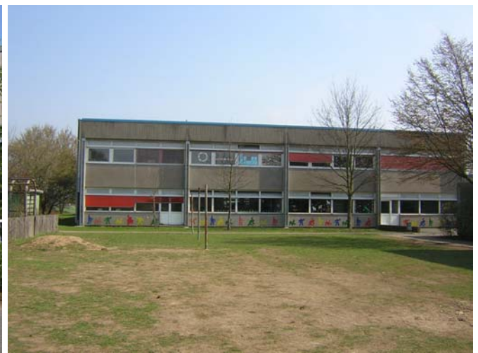
Südwest- Fassade Schulgebäude
